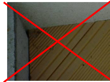
Dodržujte mezeru 5 mm mezi prkny na šířku a 15 mm mezeru mezi konci prken a zdi
