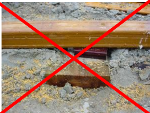
Nezapouštějte nosiče do betonu
